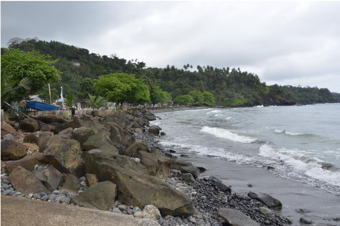
Ribeira Afonso, panorâmica ilustrando protecção da orla costeira por blocos rochosos
