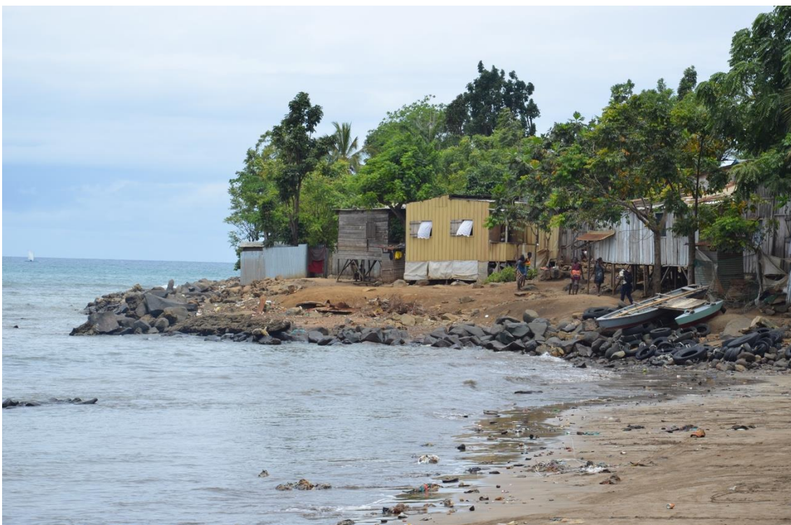
Praia Melão, vista a Sudoeste onde se observa a adopção de medidas básicas de protecção costeira
