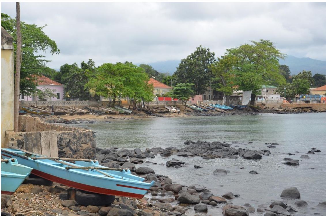
Pantufo, estreitamento da praia com redução significativa do espaço para varar embarcações e erosão junto à estrada.
