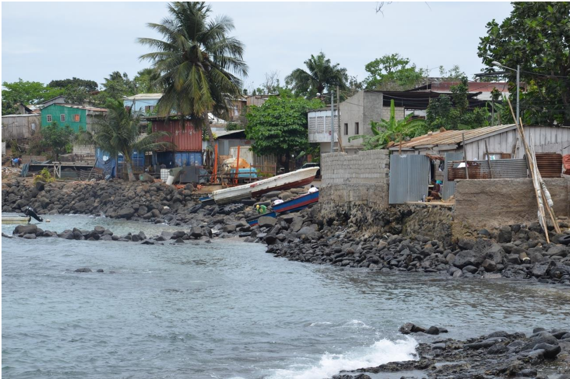
Pantufo, aspecto de enrocamentos de protecção, exposição de construções e dificuldades para varar embarcações
